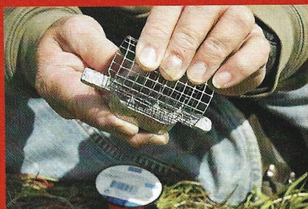
Plaats de gaaskorf met de vouwnaad tegen de loodstrip.
